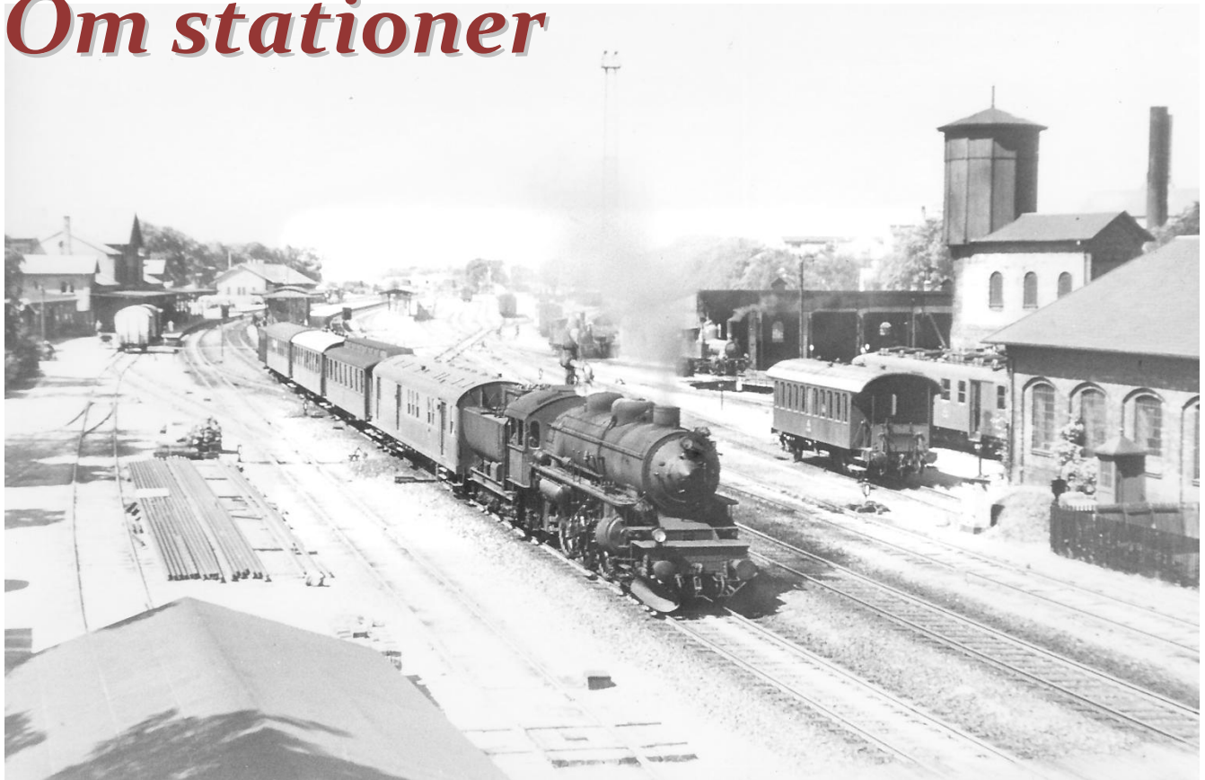
Slagelse station 1958, her er alt hvad en station kan begære!
